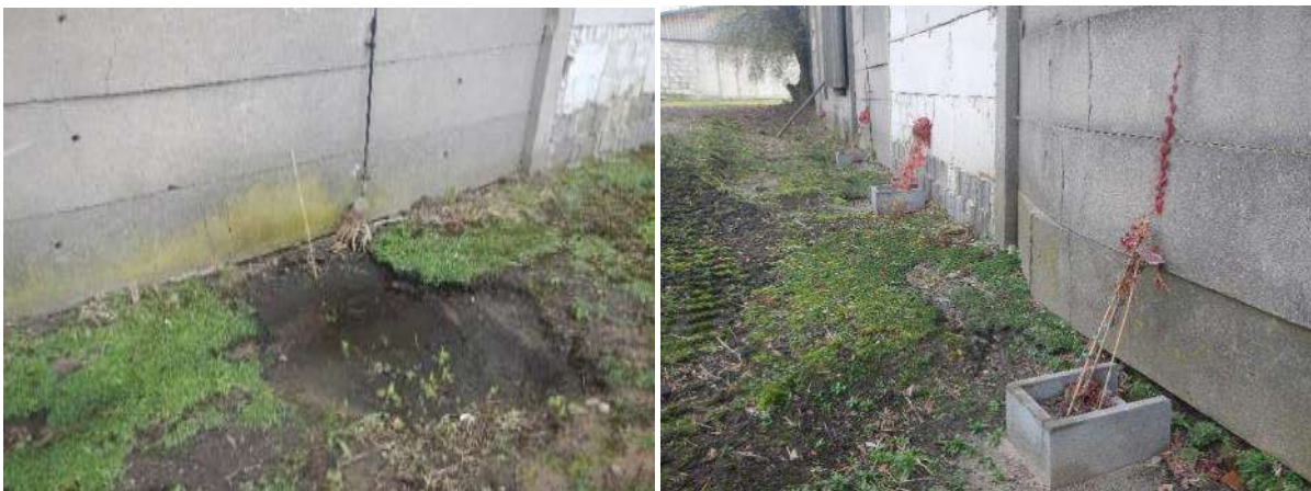
Abbildung 6: nasser Standort (Aufnahme Juni 2017), woraufhin Weinreben in Pflanzkübel gesetzt wurden (Aufnahme September 2017).
